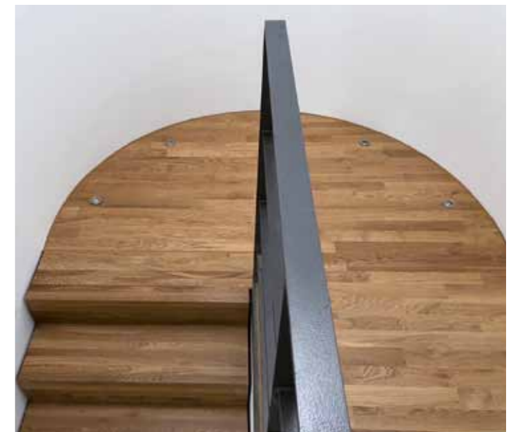
Stabparkett mit eingebauten Beleuchtungselementen Stabparkett als Treppenstufen und Treppenabsatz.
